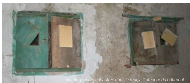
Ruche-placard encastrée dans le mur, à l'intérieur du bâtiment
